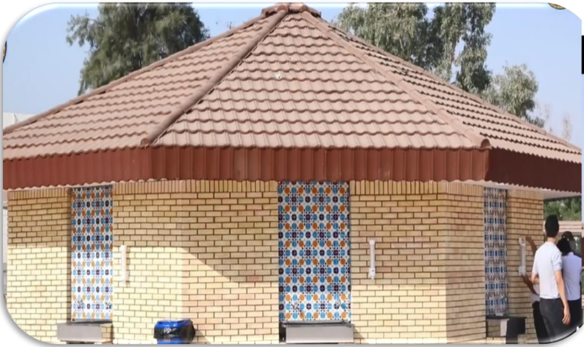
محطة مياه RO
